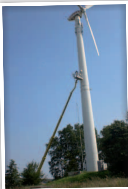
Mitarbeiter der Firma Kabelfrei aus Rosendahl montieren die zur Funkübertragung erforderliche Technik am Windrad auf dem Henrichsknübel.
